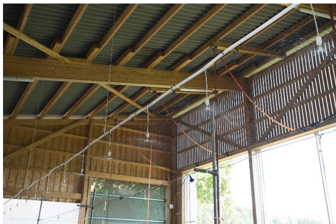
Abb. 3: Befeuchtung der Laufflächen von oben mit einer Niederdruck-Befeuchtungsanlage (Fotos: Agroscope).
