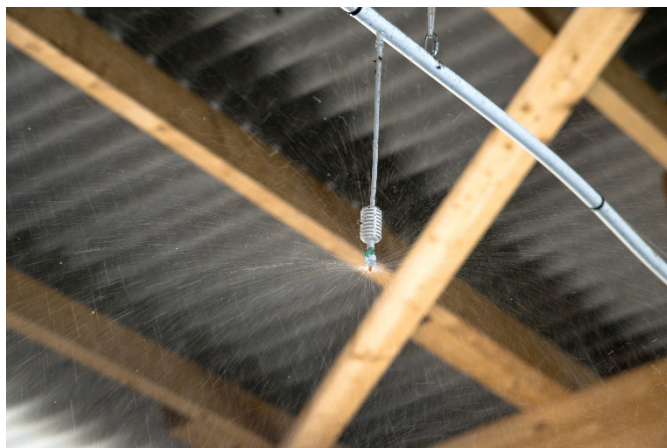
Abb. 3: Befeuchtung der Laufflächen von oben mit einer Niederdruck-Befeuchtungsanlage (Fotos: Agroscope).
