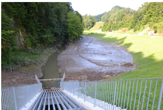
Bei den Hochwasserereignissen im Juli 2021 hat sich der Hochwasserschutzdamm ein erstes Mal bewährt.
