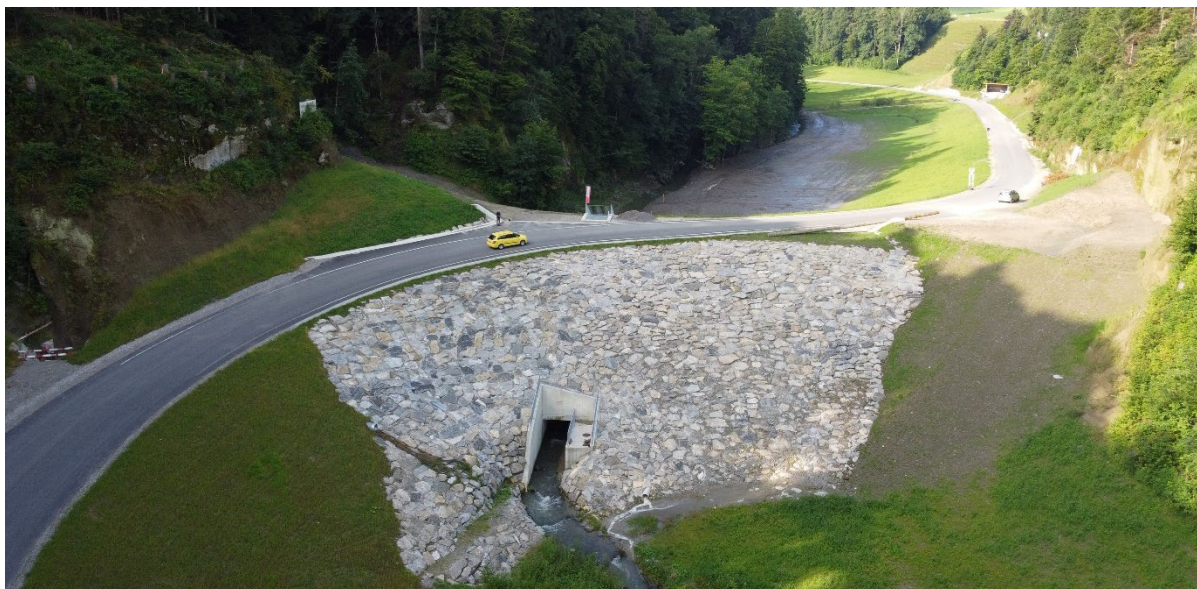
Sicht auf die Talseite des Hochwasserschutzdamms und den Einstaubereich im oberen Teil des Bildes.
