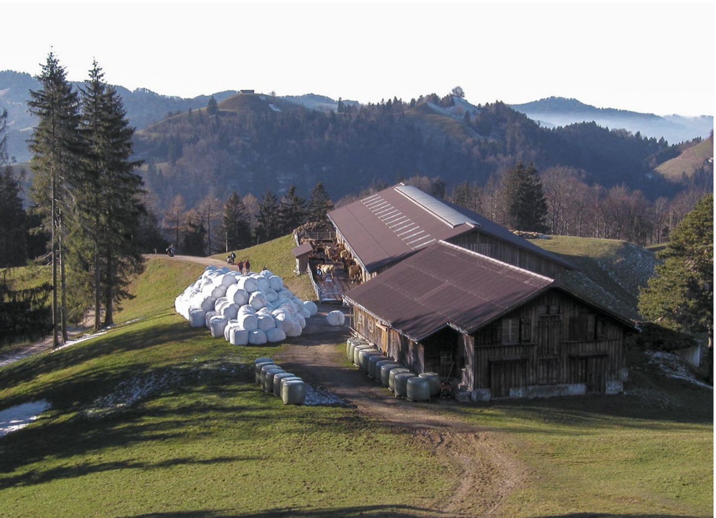
Abb. 1 | Neben der direkten Energie, die beispielsweise für die Beleuchtung oder Lüftung eines Gebäudes benötigt wird, steckt unter anderem in der Gebäudehülle und in den Folien für die Ballensilagen auch viel indirekte Energie. (Foto: Agroscope)
