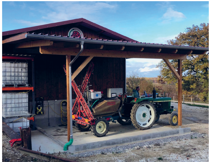
Abbildung 2: Biofilteranlage für PSM-Waschwasser im Projektgebiet. Die Massnahme erfolgte bei nachgewiesenen punktuellen Einträge durch Hofentwässerung.
