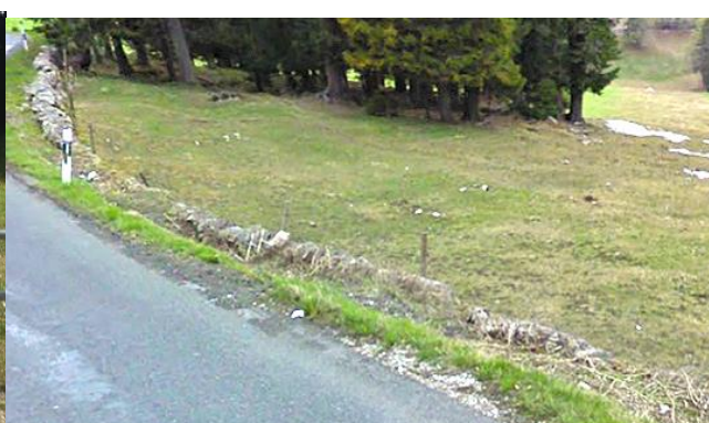
Manque d'entretien des murs en pierres sèches
