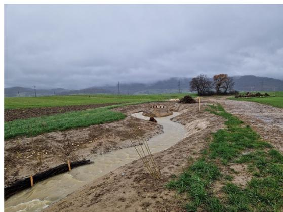
Kurz nach Bauende testen Starkniederschläge den Diebachgraben.
