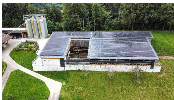
Die gesamte Dachfläche ist mit Solarpanels zur Stromproduktion belegt. Zur Vermeidung von Streuströmen sind die elektrischen Leitungen ausserhalb der Gebäudeerdung verlegt.
