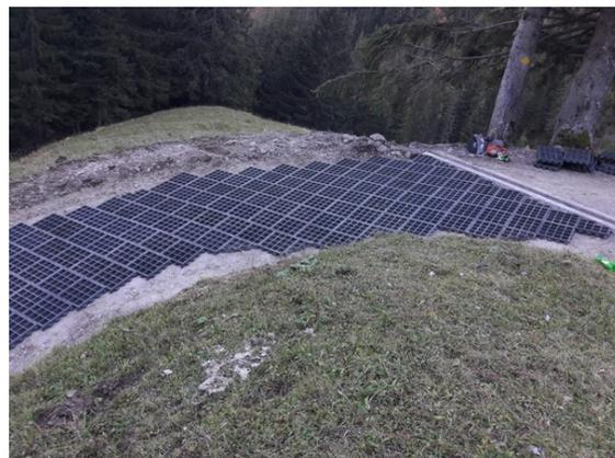
*Bodengitter vor dem Verfüllen. Die Bodengitter müssen, insbesondere auf steilen Abschnitten, gut verankert sein.*
