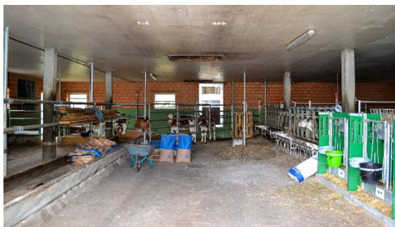
Blick in den für die Jungviehhaltung umgebauten Altstall. Gut sichtbar sind die vier betonierten, tragenden Stützen, welche eine Umbaulösung erschwert hätten.
