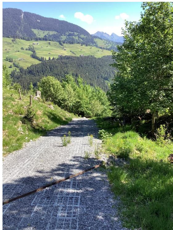
*Fertig verfülltes Kunststoff-Bodengitter mit eingebautem Querabschlag.*
