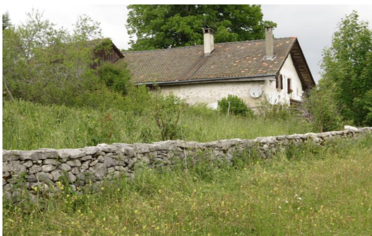
Mur de pierres sèches restauré à Chaumont
