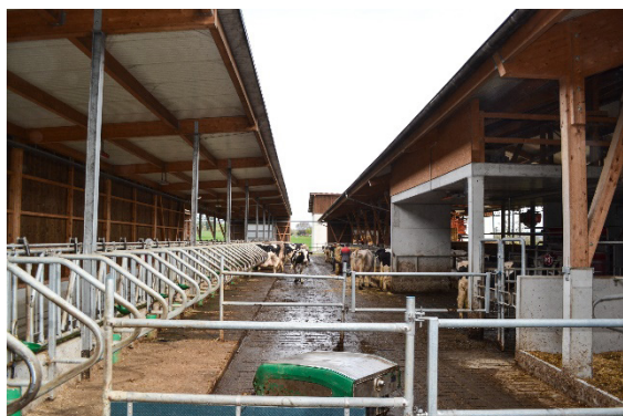
Der Laufgang entlang der Fressachse mit Mistroboter im Einsatz. Gut sichtbar sind die erhöhten Fressstände mit den Trennbügeln.
