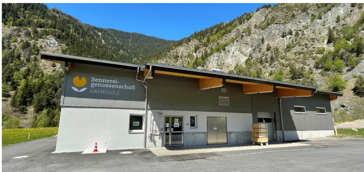
Die neugebaute Sennerei am Dorfrand von Grengiols.
