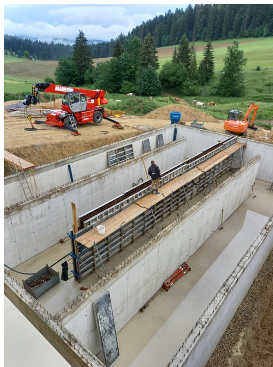
Citerne en construction
