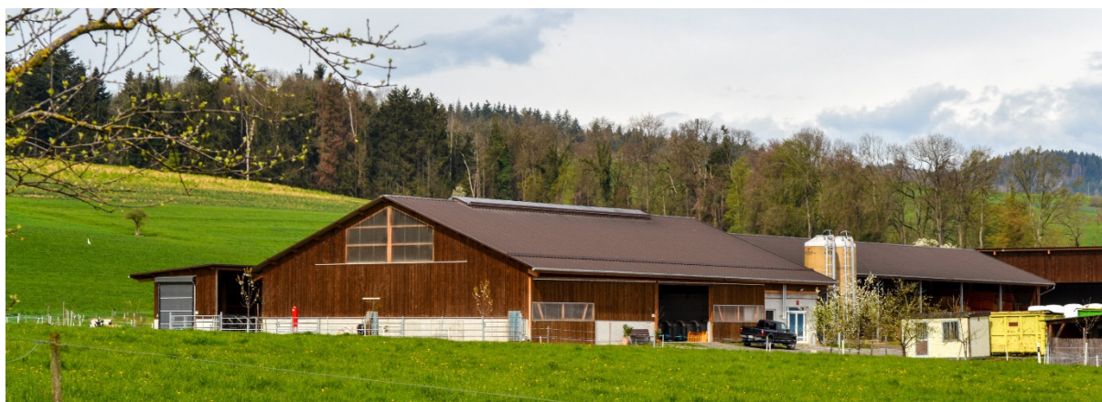
Die Stallansicht aus Südosten
