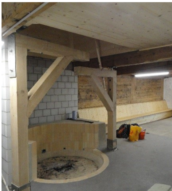
Die offene Feuergrube mit den zwei Galgen für das grosse und kleine Kessi.
