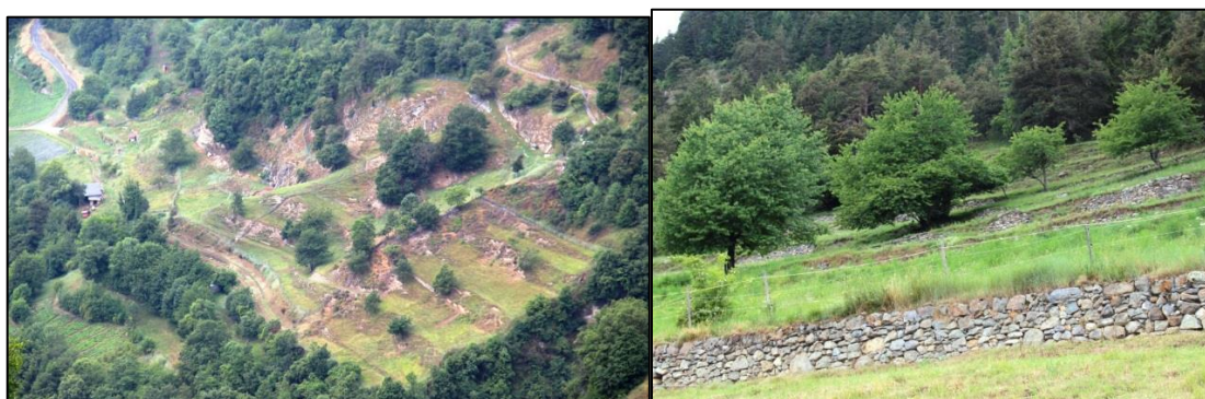
Figure 53 : A gauche, les terrasses de Buitonnaz (Fully) qui se détériorent faute d'entretien et de protection contre le passage des animaux. A droite, des terrasses à Chiboz (Fully) avec des murs en pierre sèche préservés par une gestion des clôtures adaptée, photo : VM, 07.07.2014
