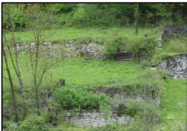
Figure 89 : Anciennes terrasses de vignes soutenues par des murs en pierres sèches qui disparaissent sous la végétation, Roche. « Côté sauvage représentatif des Coteaux, beaux murs en pierres sèches, mais marque le phénomène de déprise agricole ». (●)
