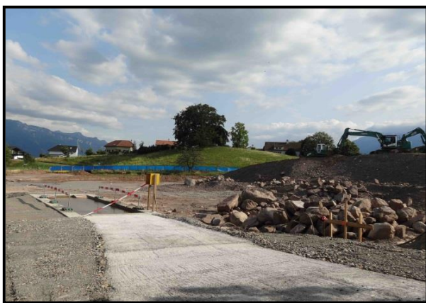
Figure 49 : Quartier en développement à Hauteville.
