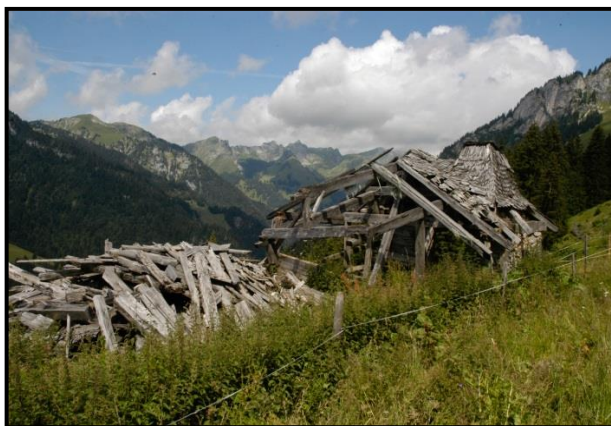
Figure 11 : Exemple de chalet d'alpage abandonné
