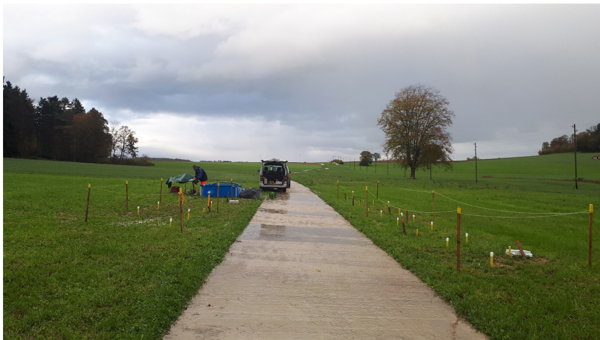
Illustration 2 : chemin en dalles de béton. Les écoulements de surface franchissant le chemin au niveau des barrages sont bien visibles (photo : E. Berdat).
