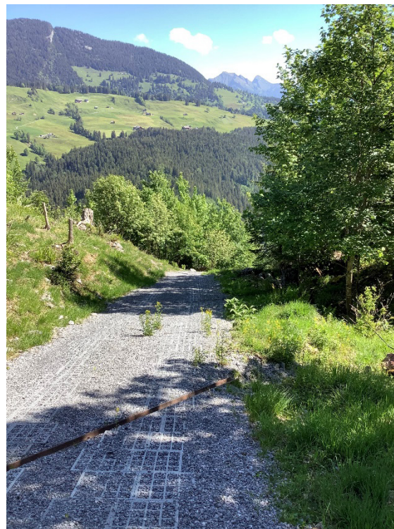
Fertig verfülltes Kunststoff-Bodengitter mit eingebautem Querabschlag.
