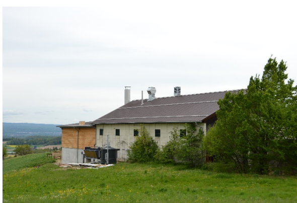
Ein Teil des Holzkraftwerkes ist in das bestehende Ökonomiegebäude integriert. Dadurch konnten das Bauvolumen und die benötigte Landfläche klein gehalten werden.
