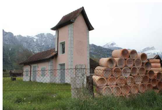
Pumpstation der Meliorationsgenossenschaft mit Trafostation
