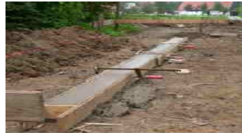
Semelle filante en béton coulé sur place
