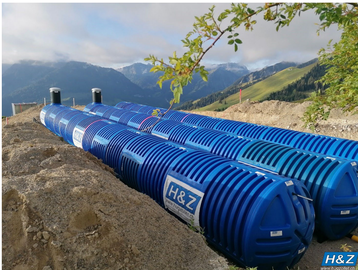
Dimension particulière des citernes : 19m de long pour 2.20m de diamètre.
