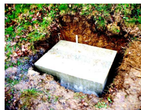
Fondazione costituita da più elementi di calcestruzzo
