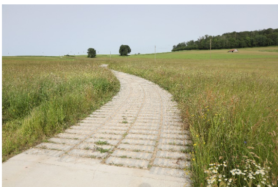
Abbildung 1: Detailaufnahme der Strasse in Betonlementbauweise (Foto: Ph. Grosvernier).
