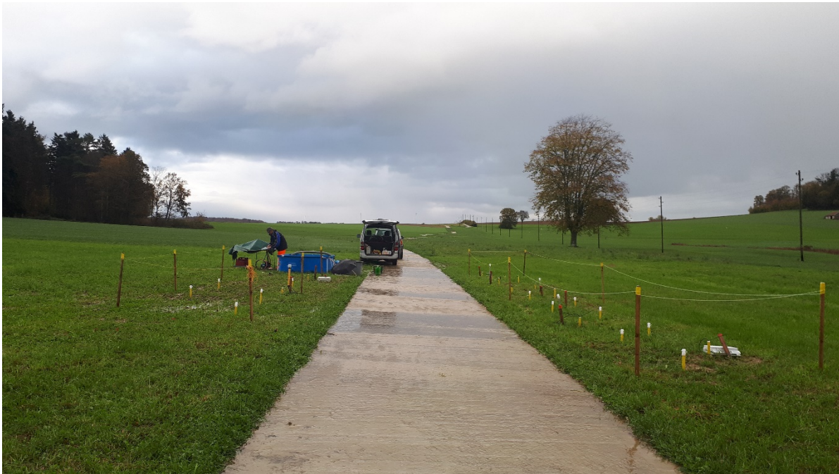
Abbildung 2: Strassenbauweise mit Betonplatten. Die Fliesswege über die Strassenoberfläche auf Höhe der Quersperren sind gut erkennbar (Foto: E. Berdat)
