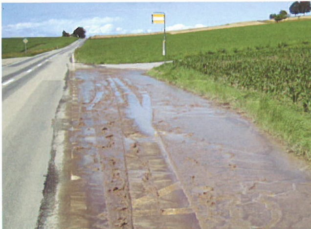
Durch Erosion verschmutzte Postautohaltestelle.
